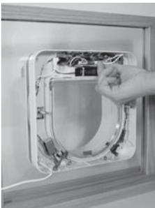
Stecken sie das Scanner Kabel in die Elektronik und befestigen sie den äusseren und inneren Teil mit den zwei M6 Schrauben. Ziehen sie die Schrauben an um das Smart Flap in der gewünschten Position zu halten.
