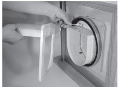
Wenn sie das Smart Flap in eine Öffnung fügen platzieren sie den Innenteil samt Tunnelansatz und passieren sie dann das Scanner Kabel vom Aussenteil. Durch das rechteckige Loch des Innenteils.
